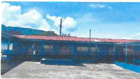
Foto 3: Sustitución de lámina por lámina troquelada en 3 salones
